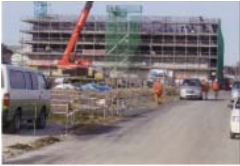
国分堀割部試験工事
