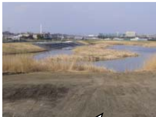
現在、工事中の国分川調節池
